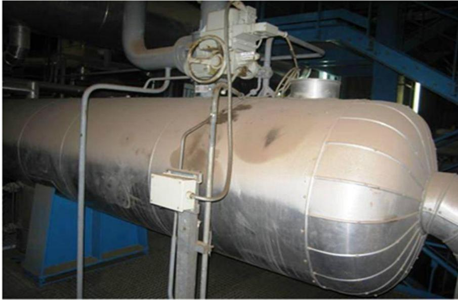
Fig. n°(11) : Vue de réchauffeur basse pression (BP).
