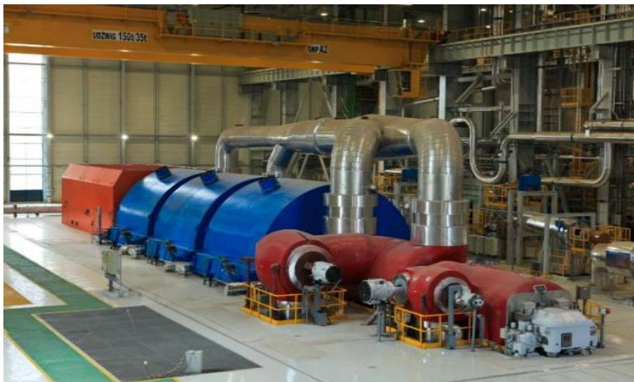
Figure II -4: L'ensemble turbine à vapeur [12]
