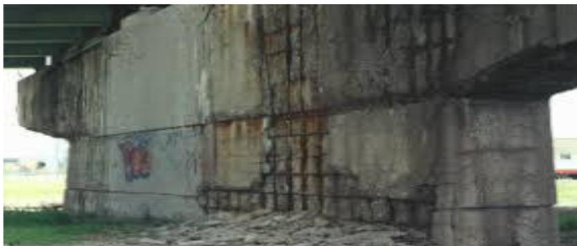
**Figure 4:** action des chlorures sur les bétons
