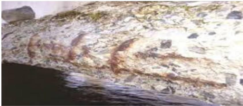
**Figure 3:** action des sulfates sur les bétons
