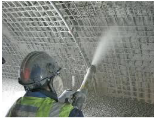
Figure I-16: Béton projeté
