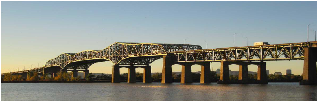
Figure I-17: Réfection du pont Champlain en BHP.
