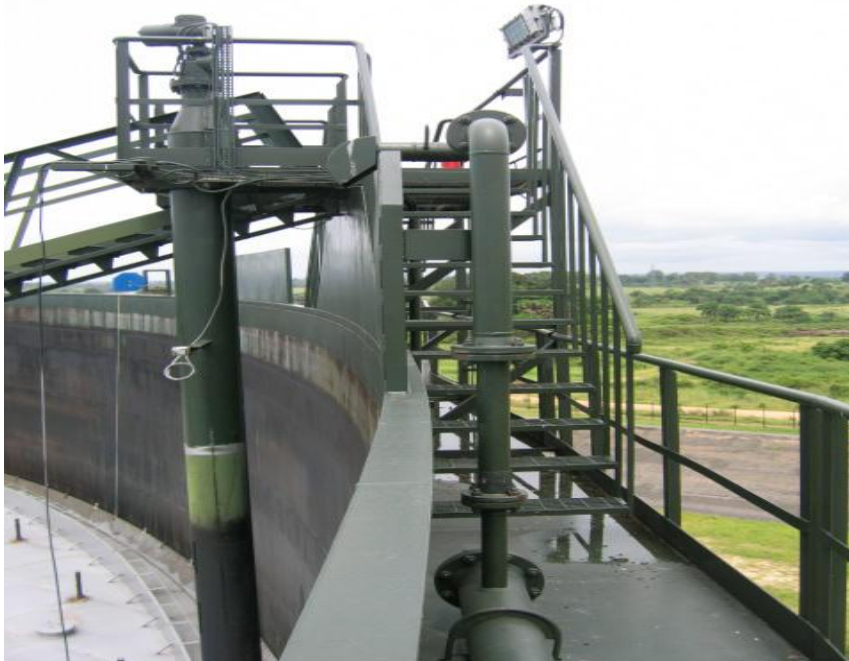
Fig. II.6 : les accessoires d'accès au réservoir
