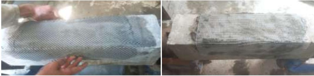
**Figure IV.12** : positionnement des grilles en fibres de verre et métallique.
