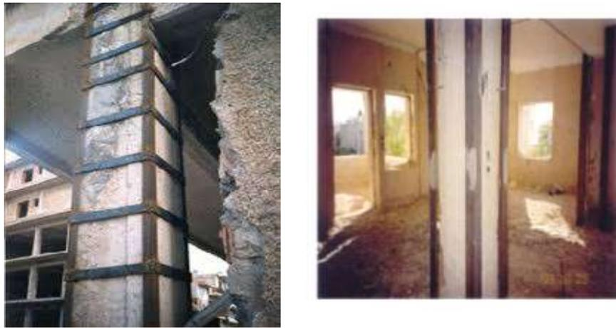
**Figure II.4:** Renforcement de poteaux au moyen de profilés métallique.
