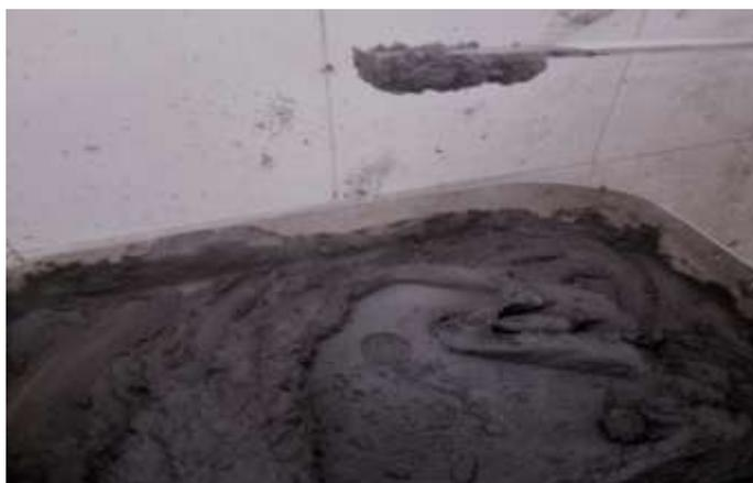
**Figure IV.8 :** le mortier de réparation
