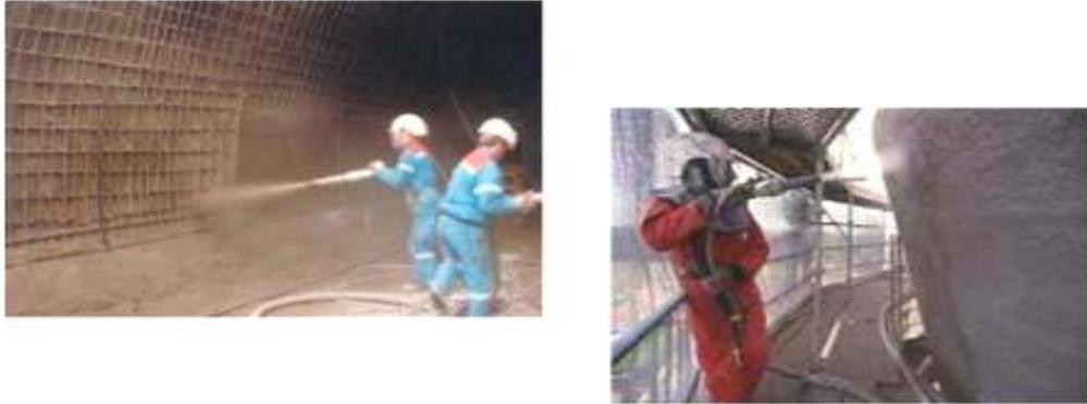
Figure II.3 : Renforcement au moyen de béton projeté [1]
