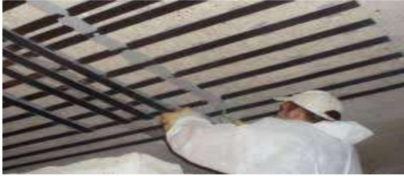
**Figure II.8 :** renforcement des dalles par les PRF
