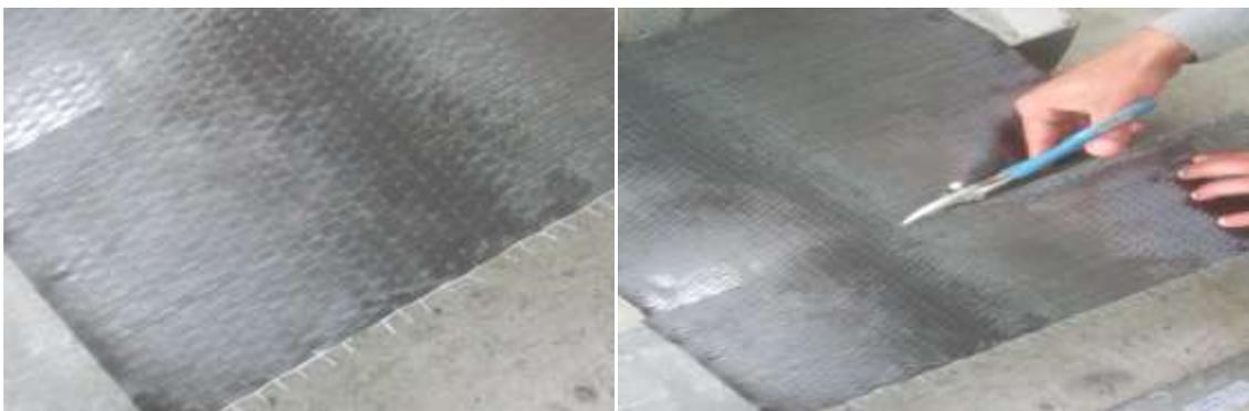
**Figure IV.15** : découpage de fibre de carbone
