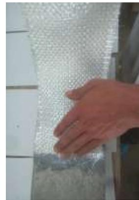
**Figure IV.18**: positionnement des matériaux composite (PRFV) et (PRFC)
