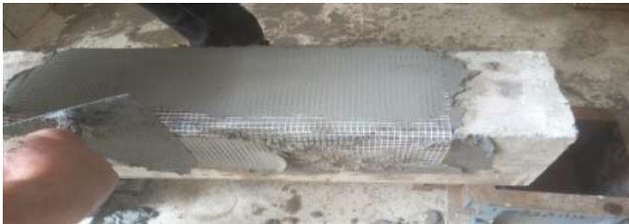
**Figure IV.13** : application de 2ème couche de mortier sur le support
