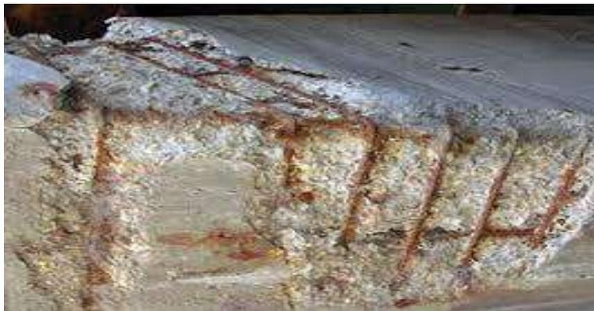
**Figure. I.3** : réaction alcalin granulats [13]
