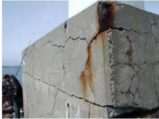
**Figure. I.4** : réaction sulfatique interne [4]
