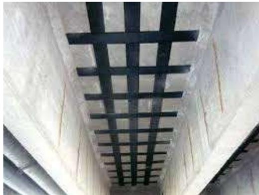
**Figure II.6:** Une poutre en béton armé renforcée par une lamelle en PRF (Smith et Teng 2002) [9]
