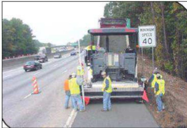
**Figure I.6 :** Mise en place du BCR en pavage - Atlanta USA.
