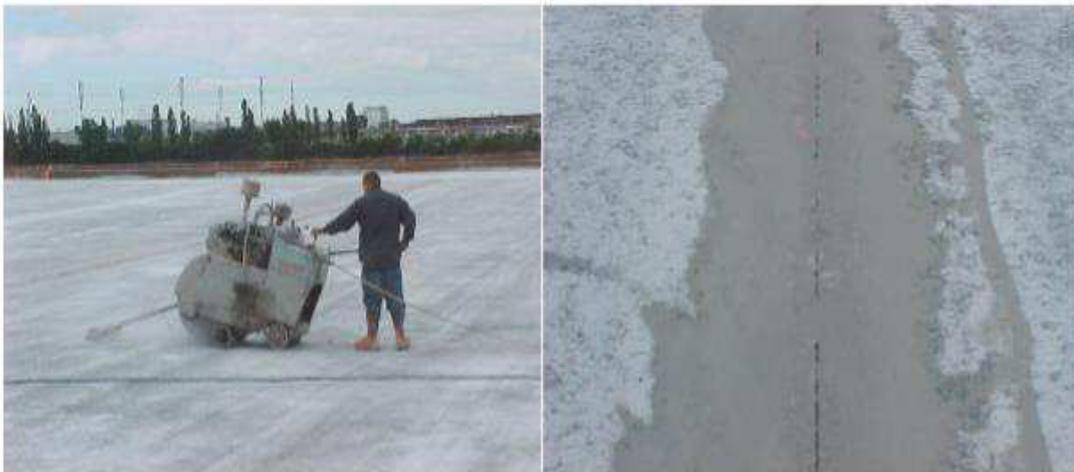
**Figure I.10** : Exécution de joints par sciage après mise en place du BCR.
