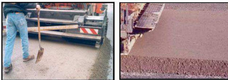
**Figure I.19** : Texture du BCR avec un finisseur à haut pouvoir de compactage.
