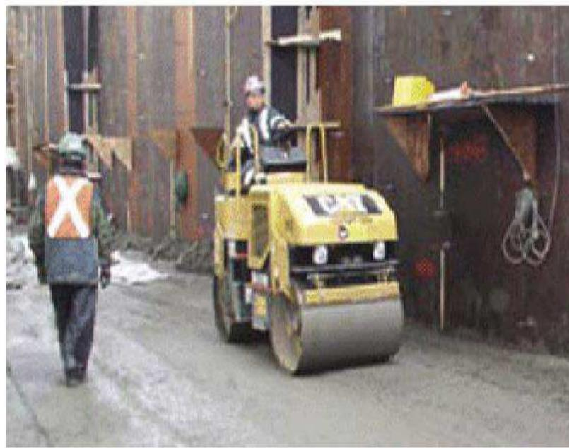
Figure I.5 : Barrage et Batardeau en BCR sur la rivière Manouane au Canada.
