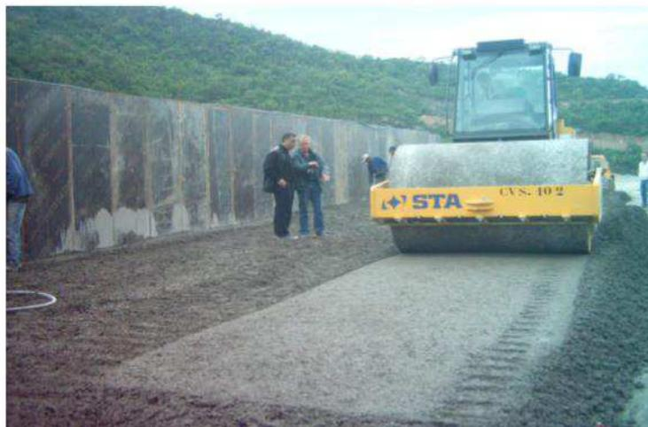
**Figure I.3 :** Compactage du BCR (Barrage en BCR Errmil - Tunisie)
