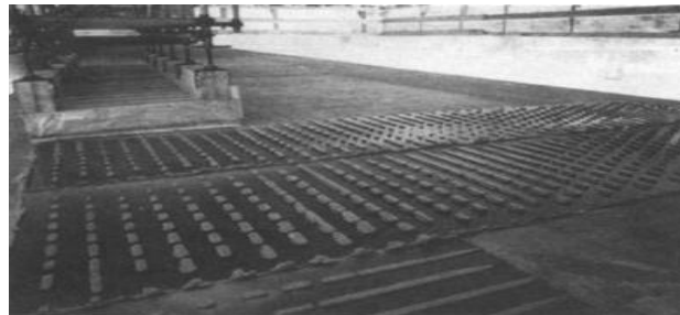
Figure II.5 : Plaques d'acier collées [9].
