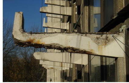
Figure I.1 : Structures atteintes par la carbonatation [6].
