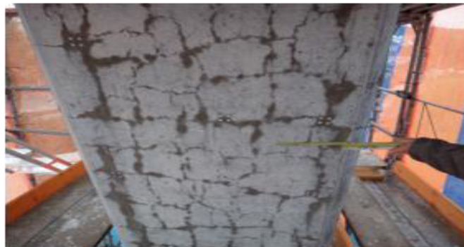
Figure I.4 : épaufures dues à l'alkali-réaction [5].
