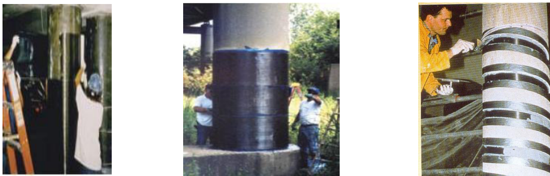
Figure II.14 : confinement des poteaux par stratification directe. [2].
