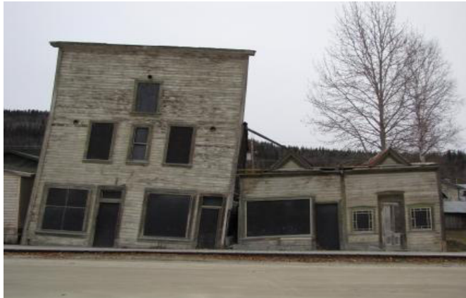
Figure I.6 : Tassement différentiel [1].
