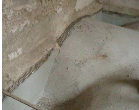
Figure II.27 : Renforcement d'une chambre forte par TRM [8].
