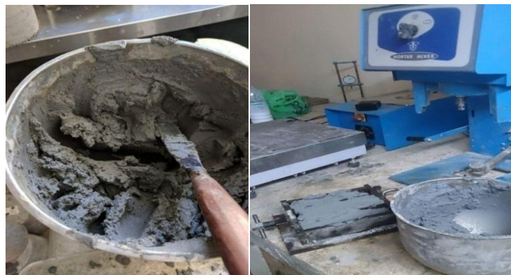
Figure III.20 : Préparation du mortier de réparation.
