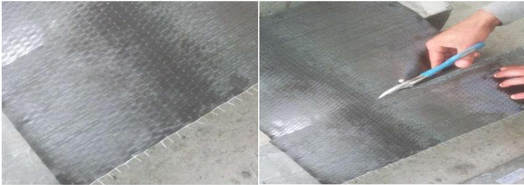
Figure III.23 : découpage de fibre de carbone.
