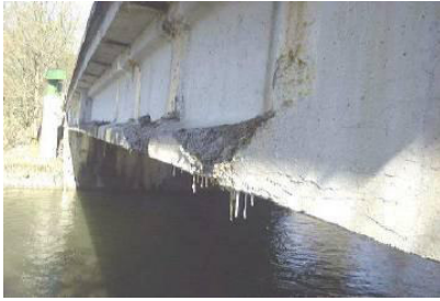
Figure I.1 : Structures atteintes par la carbonatation [6].
