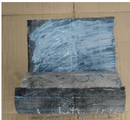
Figure III.25 : Application de la couche de colle sur la surface de béton .
