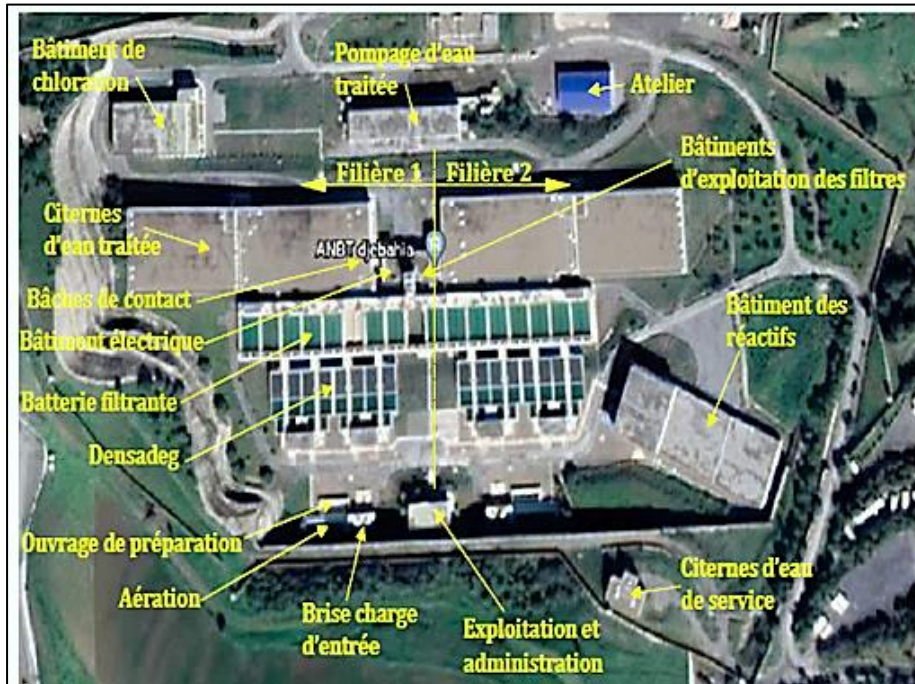
Fig. 1 – Photo satellite de la station de traitement de Koudiet Acerdoune
