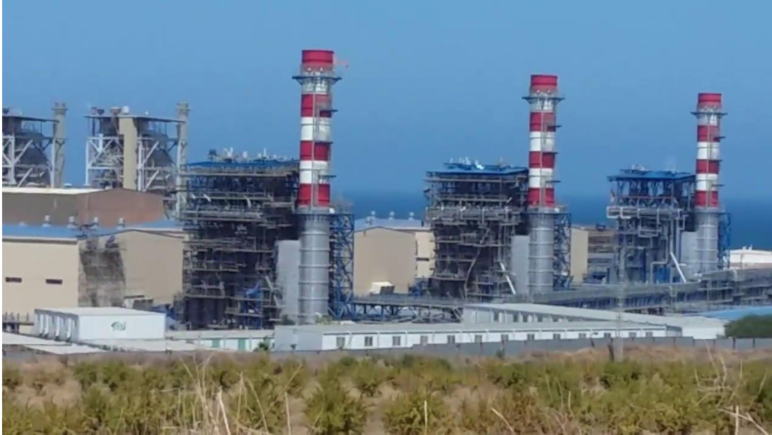
FIGURE I.9 : VUE DE LA CENTRALE A CYCLE COMBINE RAS-DJANET.
