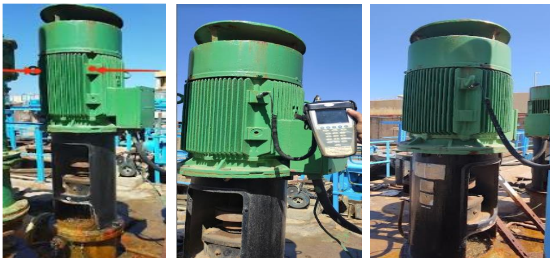
Figure 46 : Positions de mesures 1er palier
