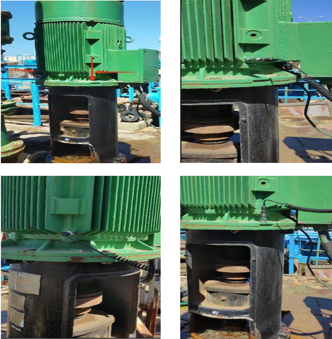
Figure 47 : Positions de mesures 2eme palier
