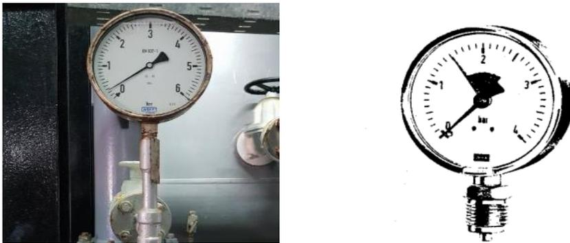
**Figure 3.2 :** *Capteur de pression (manomètre).*
