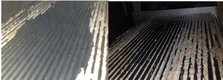
Figure IV 4: Après nettoyage manuel
