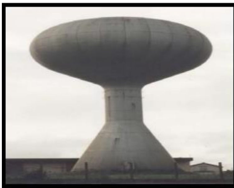
Figure II.2 : Réservoir à forme Sphéroïde.
