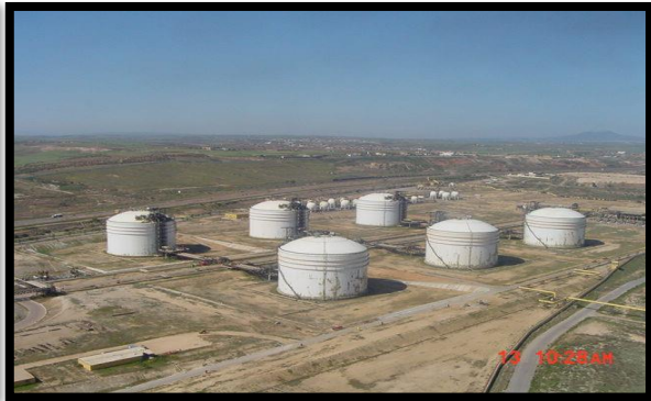
Figure I.3 : Les bacs de stockage
