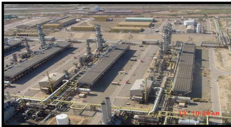
Figure I.4 : Les trains de traitement du GP1/Z
