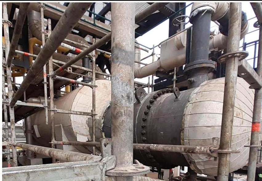
**Figure 2.16 :** Condenseur horizontal côté tube (32-E-8006 A).
