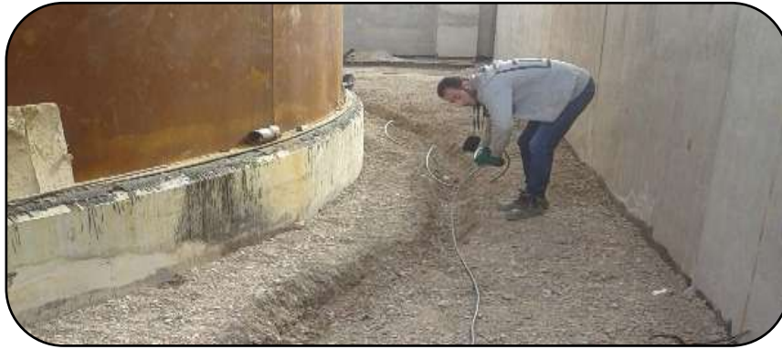
Figure IV-8 : Opération de câblage.
