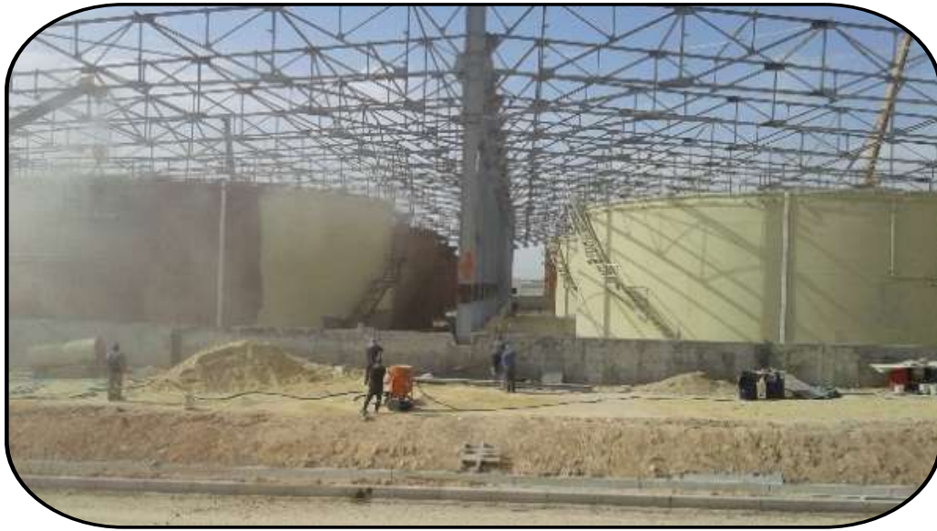
Figure IV-11: Préparation de surface.
