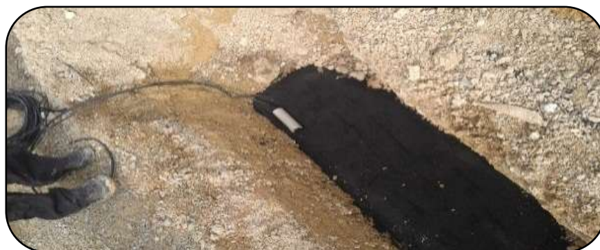
Figure IV-7 : Pose de l'électrode de référence.
