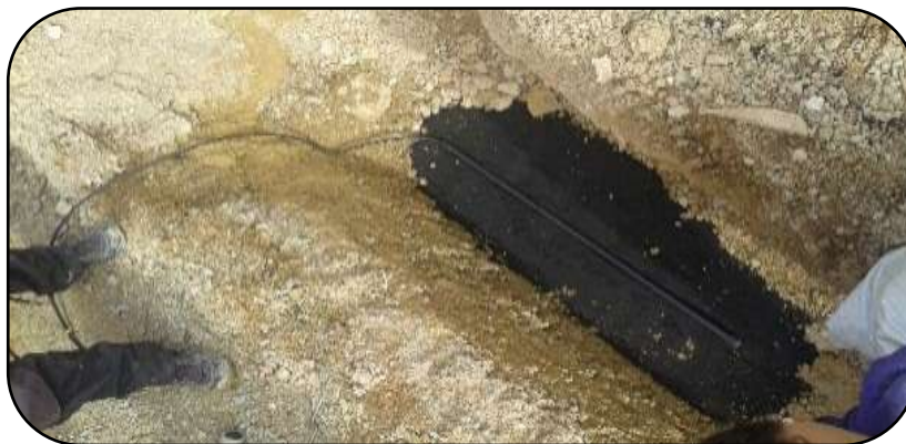
Figure IV-6 : Pose de l'anode.
