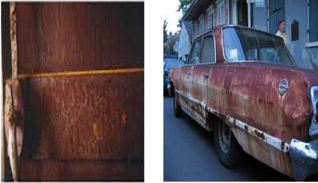
Figure IXXXII-4 : Corrosion généralisée : exemple d'une porte et d'un véhicule corrodés.
