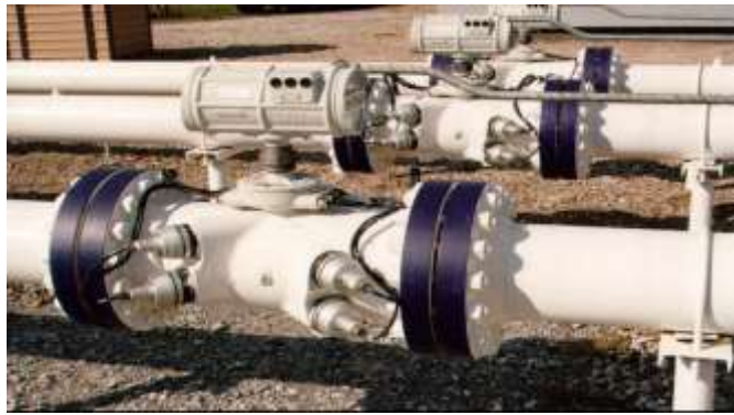
Figure II.10 : Débitmètre à ultrasons
