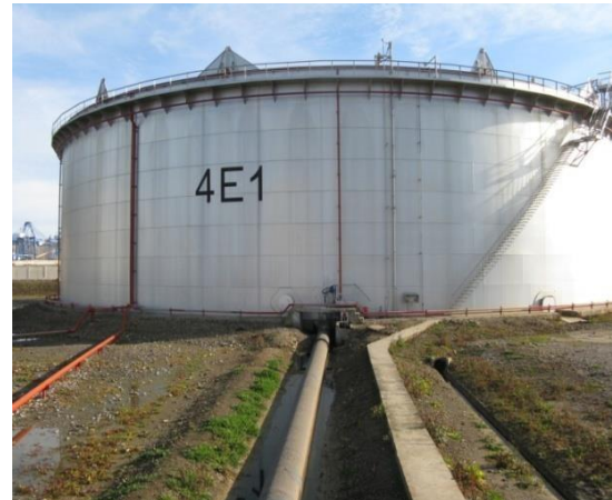
Figure I.7 : Bac de stockage 4E1
