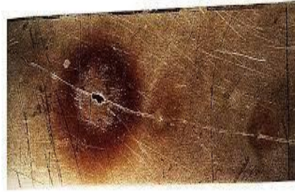
Figure II.4 : Corrosion par piqûres
