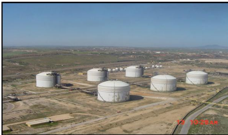
Figure I. 4 : Bacs de stockage des produits finis GPL
