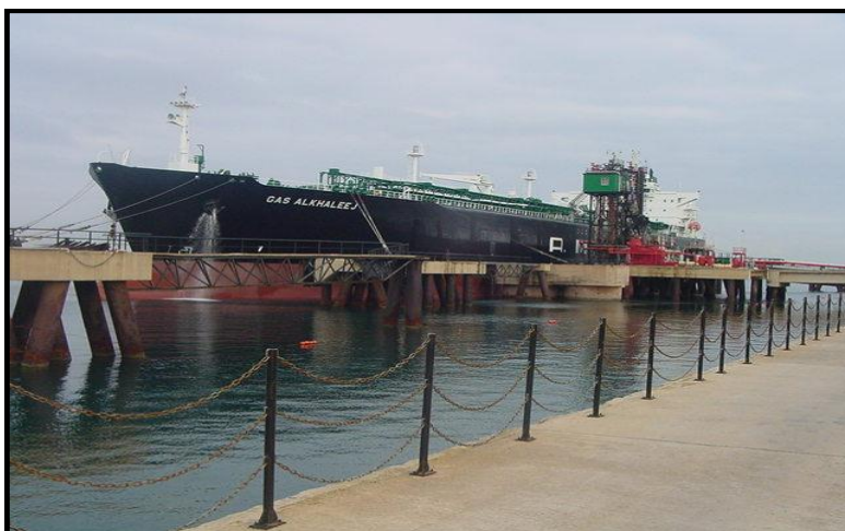
Figure I.6 : Quai de chargement de Navire du GP1/Z
