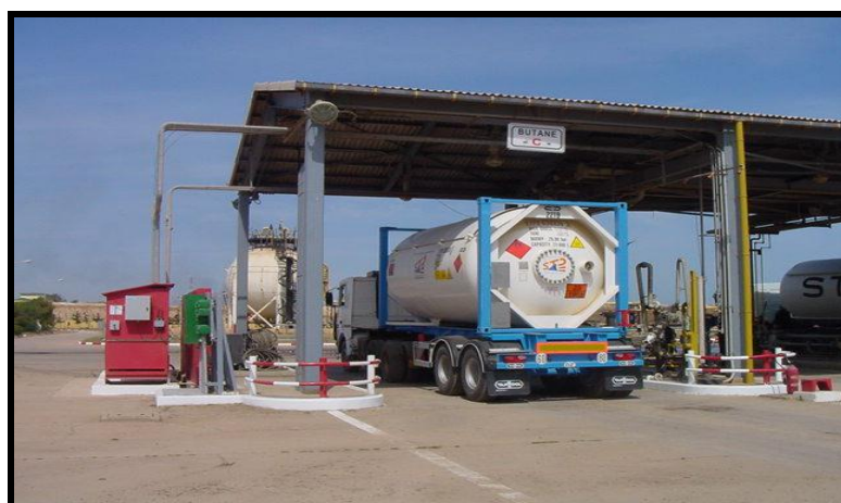
Figure I .5 : Rampe de chargement de camions du GP1/Z
