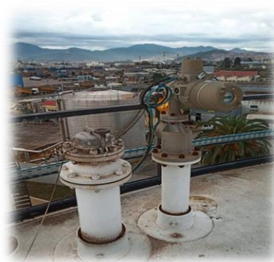
Figure I-6 Détection de niveau
