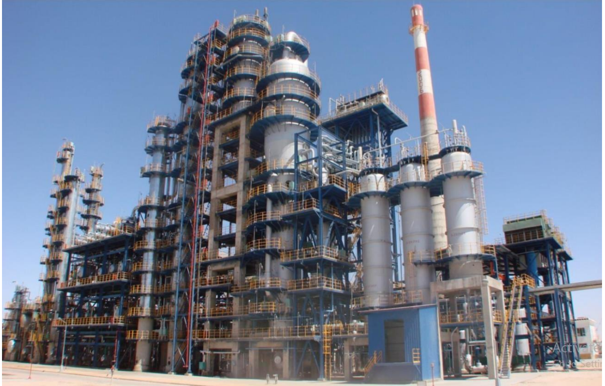
Figure 4.1. Vue partielle des sections Réacteur/Régénérateur et Fractionnement
