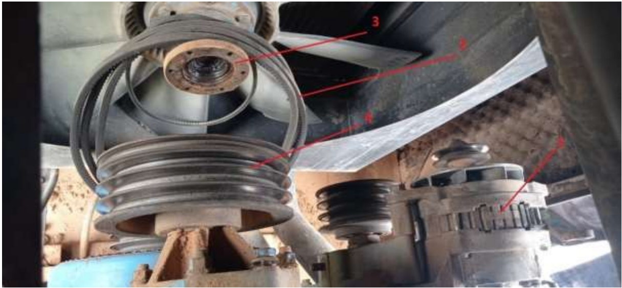
Figure 2. Démontage roulement (voir gamme démontage G01)
