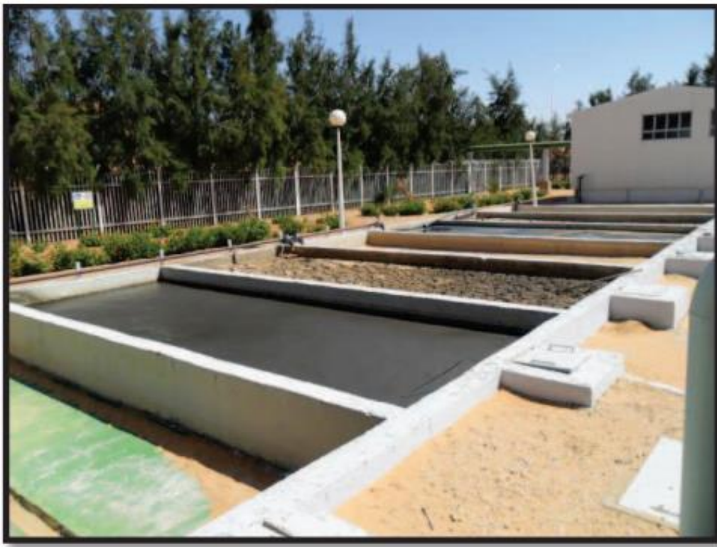
Photo II.8. Lit de séchage
