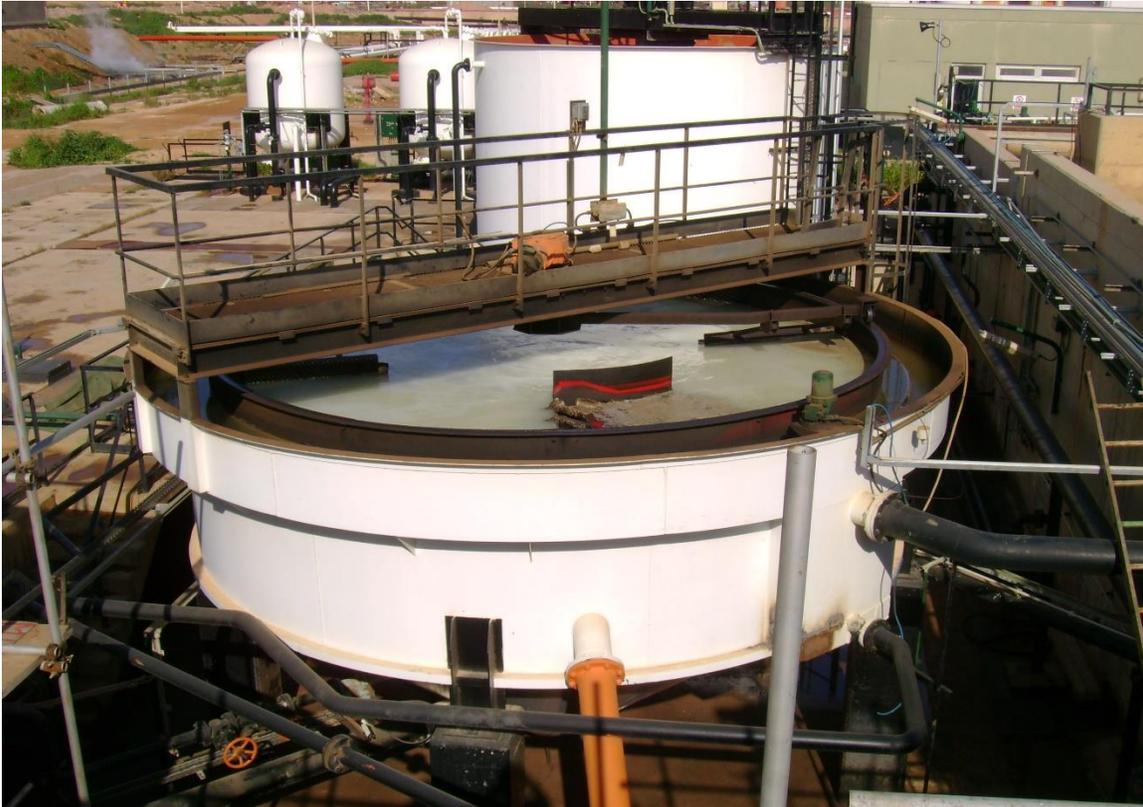
Figure N°III.6: Système de flottation DAF
