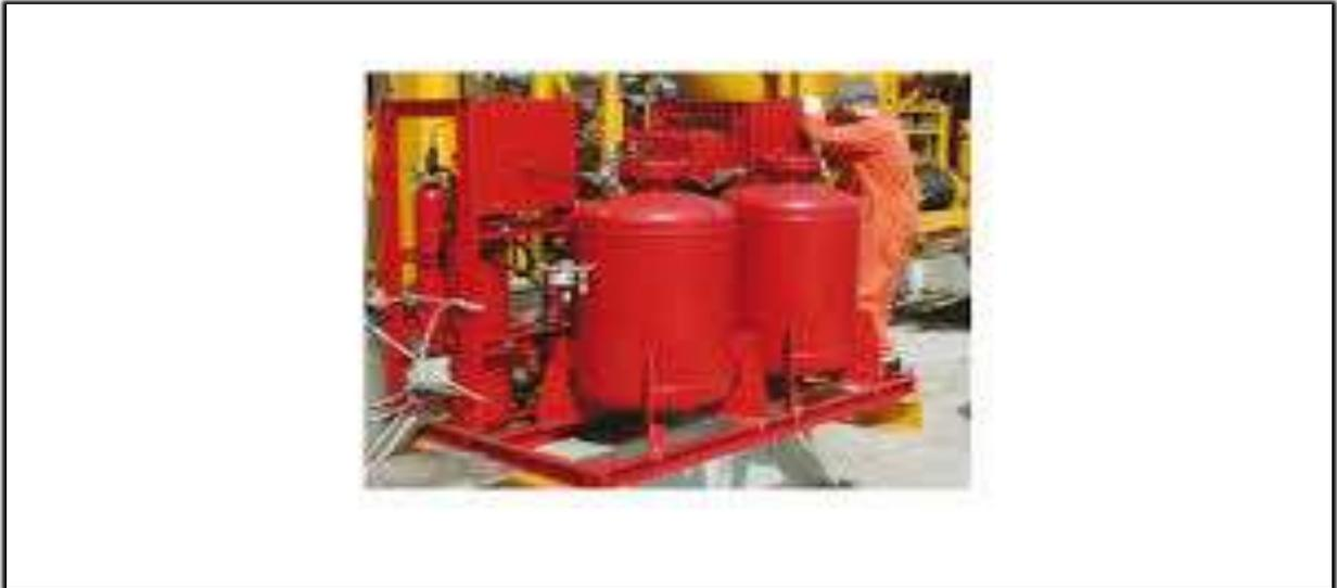
**Figure II –2-1-1 : Bouteille de la poudre accompagnée d’une bouteille de chasse d’azote**
