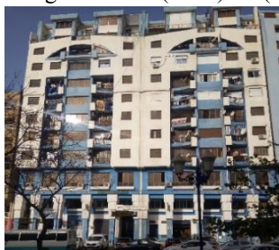
(d) dual wall-frame building in Zone 3 (1999)
