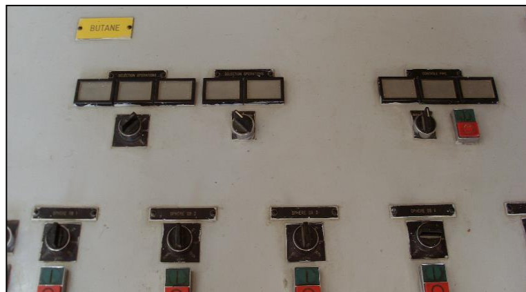
Figure II.14 : commande de sélection des différentes opérations Butane.
