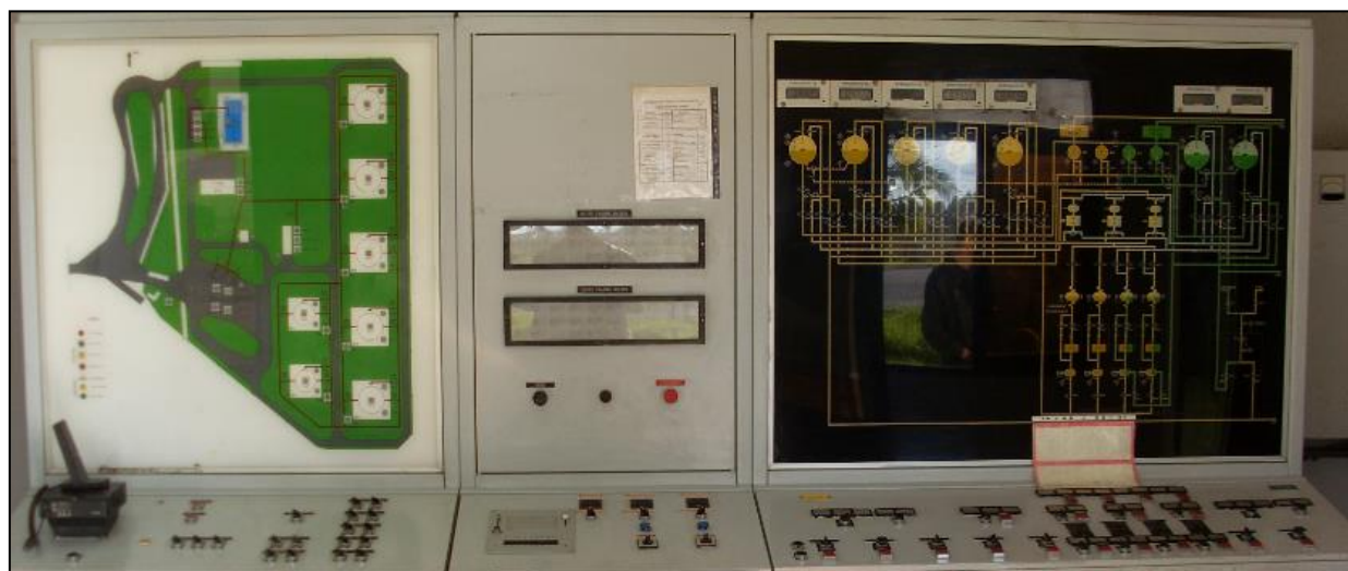
Figure II.13 : Tableau synoptique et schématique process G.P.L et incendie.
