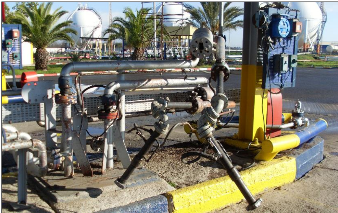
Figure II.10: Bras de chargement (liquide et gaz).
