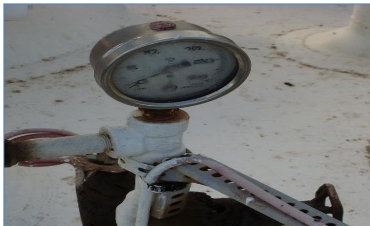
Figure III.1 : Manomètre au niveau de la sphère.
