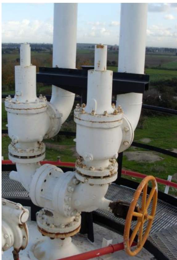
Figure II.18 : Soupape de sureté.
