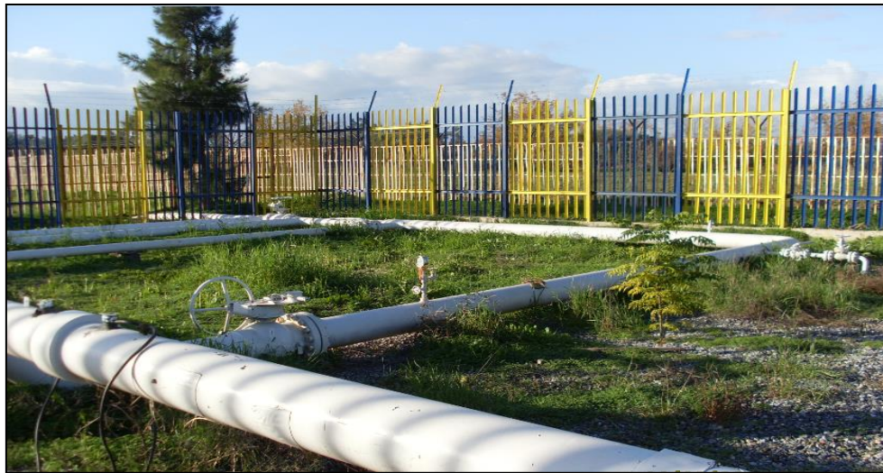
Figure II.2 : Pipe du Port Pétrolier.
