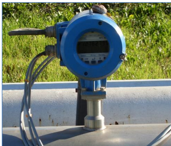
Figure III.5 : Débitmètre massique.
