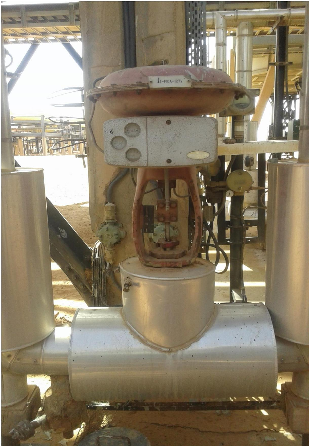
**Figure II.29** Illustration d'une vanne réelle installée sur la conduite de gaz
