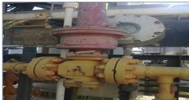
Figure I. 11 Vanne de contrôle de pression.
