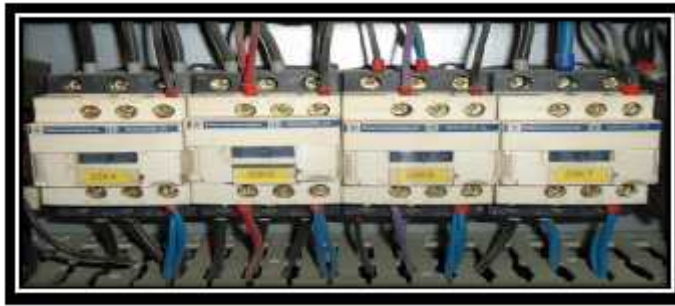
Fig II.11 Contacteur
