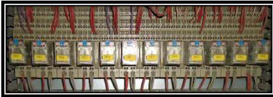
Fig II.13 Relais électromagnétique
