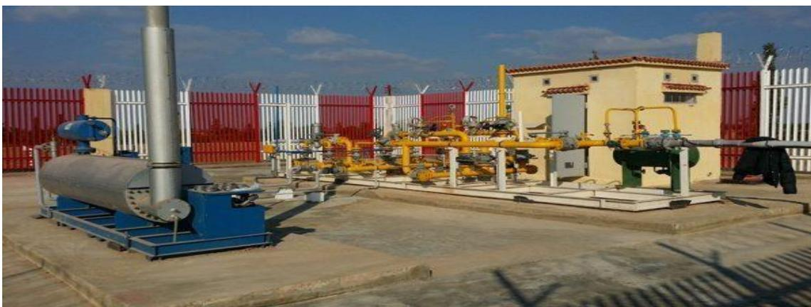
**Figure I.8 : Poste de sectionnement**
