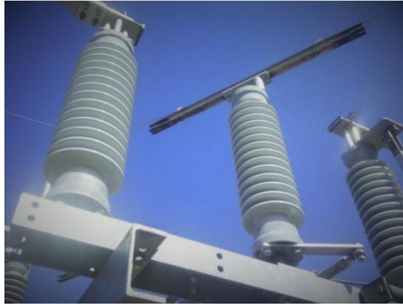
Figure I- 7: Installation de sectionneur
