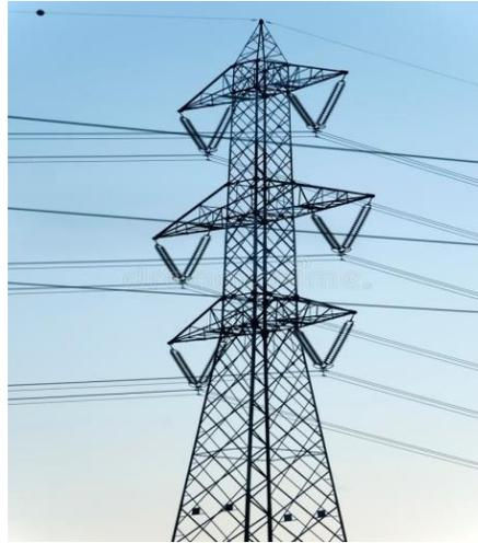
Figure I- 18: Pylône Double drapeaux
