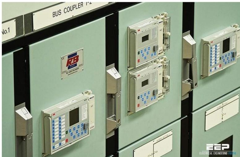
Figure I- 10: Salle de commande (Relais et automates)
