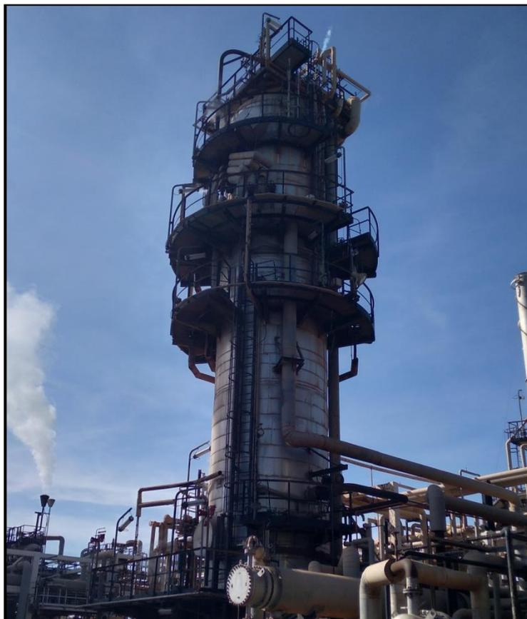
**Figure III-6:** Image correspond à la colonne d'extraction "Désasphaltage au propane"
