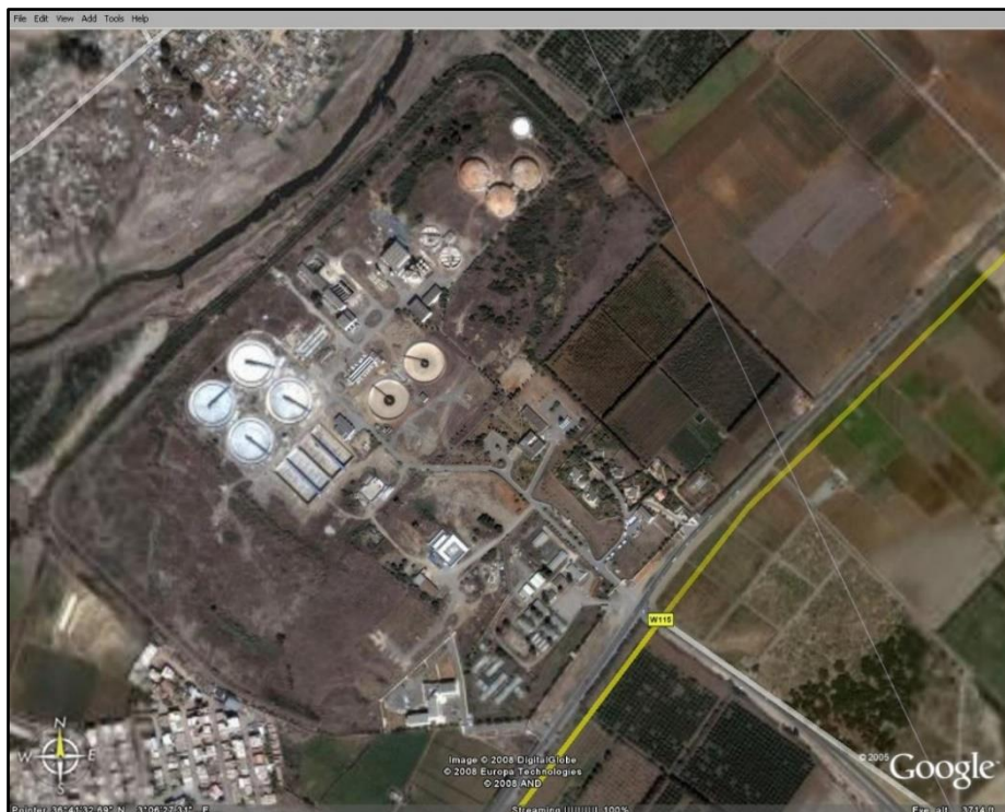
Figure I.1 : Situation géographique de la raffinerie
