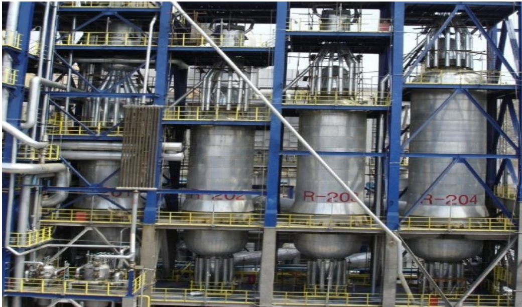
Figure II.4 : Illustration des 4 réacteurs en série de l'unité CCR
