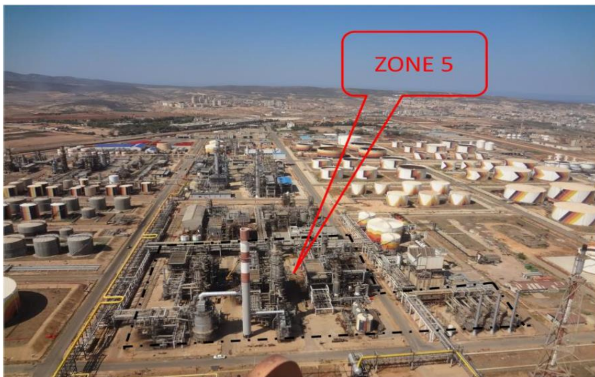
Figure II.4 Image réel de la zone 5
