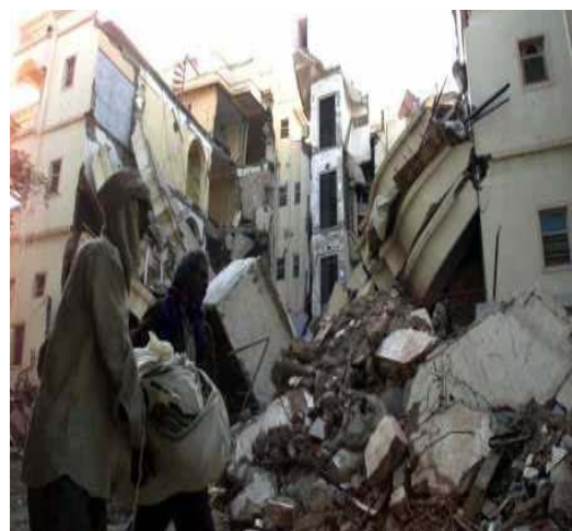
Désagrégation complète de bétons de mauvaise qualité
