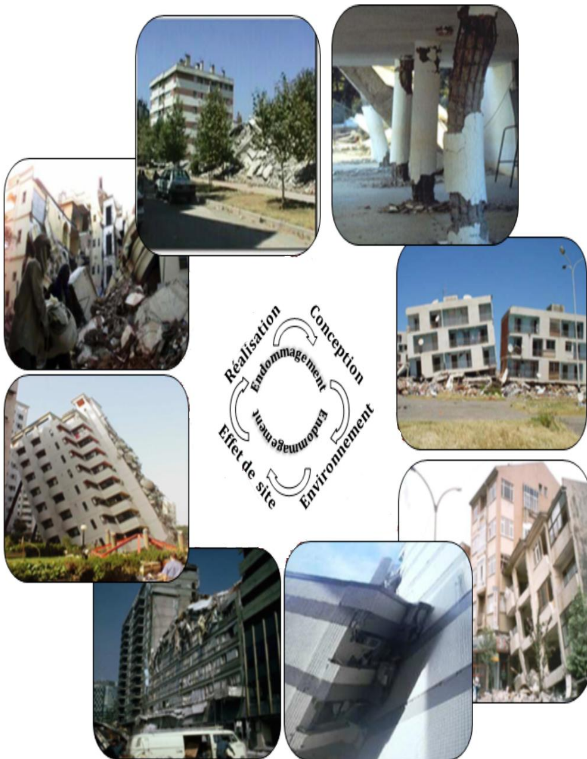
Photo 1.3 : Causes de désordres des structures en béton armé [1]
