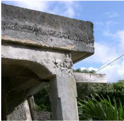
Reprise de bétonnage dans la zone critique
