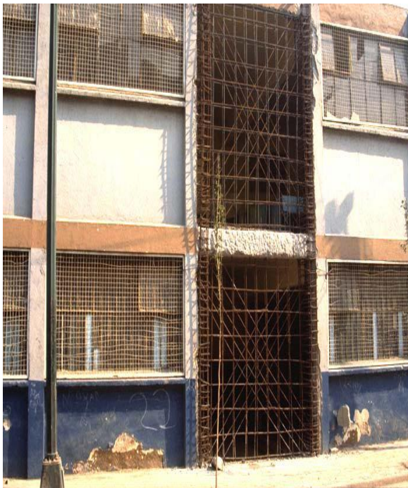
Photo 3.5 : Renforcement d'une structure à l'aide d'une nouvelle structure [6]
