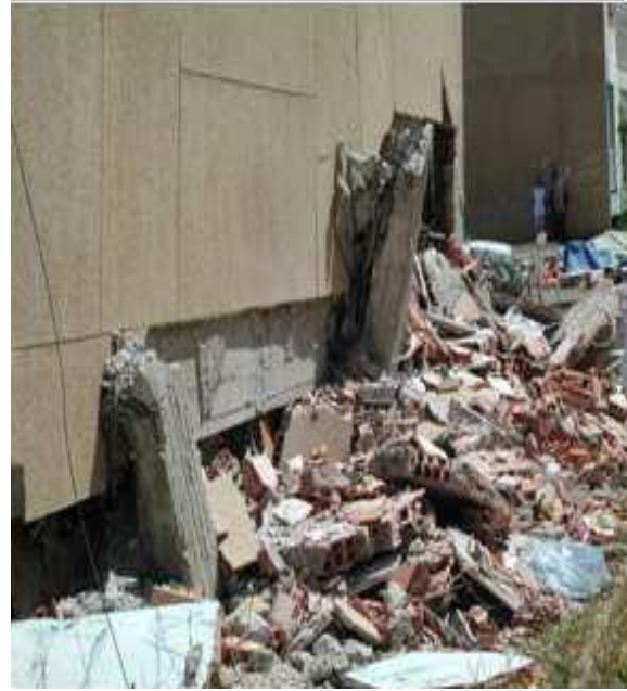
Rotules plastique dans les poteaux (nœud supérieur et inférieur)
