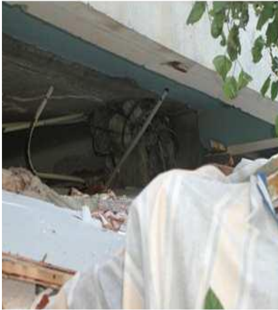
Rotules plastique dans les poteaux (nœud supérieur et inférieur)
