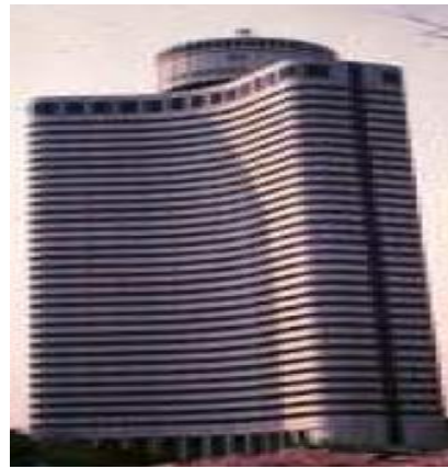
Photo 1.4 : Solutions pour remédier au problème des angles rentrant / sortant [2], [3]
