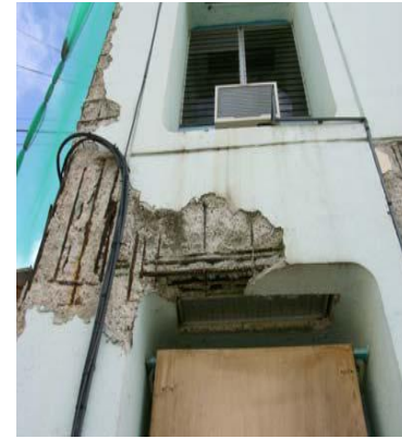
L'enrobage ne respecte pas les dispositions réglementaires
