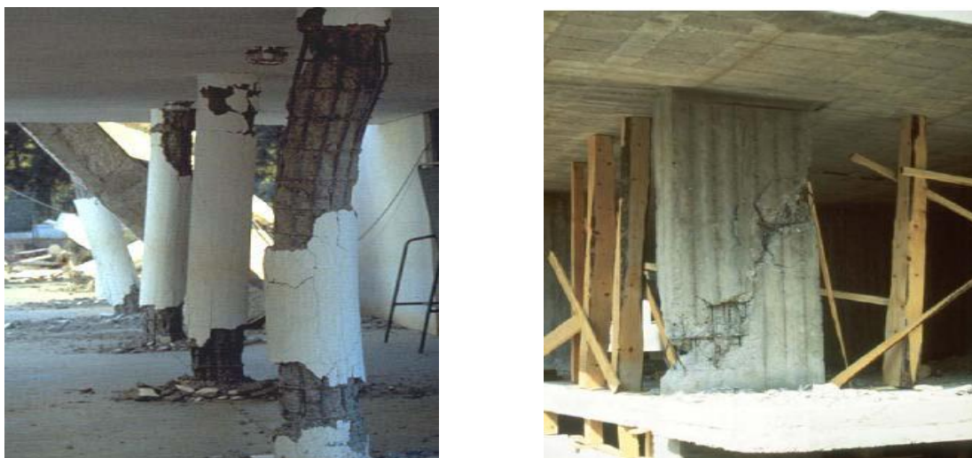
Photo 1.9 : Mode de ruine des éléments élancés [1]
