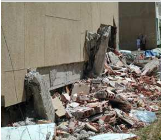
Photos 7.8 : Pathologique observés aux bâtiments des 1200 logements suite au séisme de Zemmouri 2003 et ceux de l'analyse statique non linéaire par SAP2000
