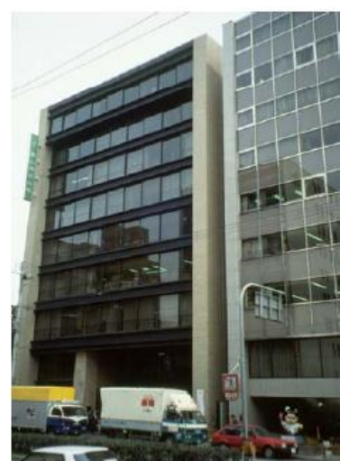
Joints parasismiques bien
