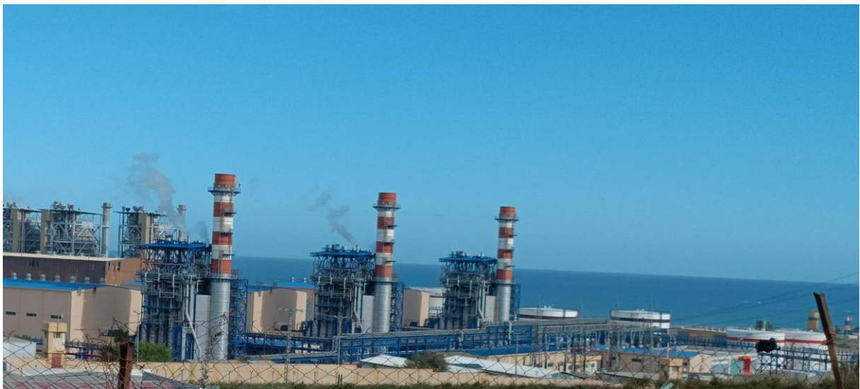
Figure I-2 : Vue externe de la centrale à CC RAS-DJINET
