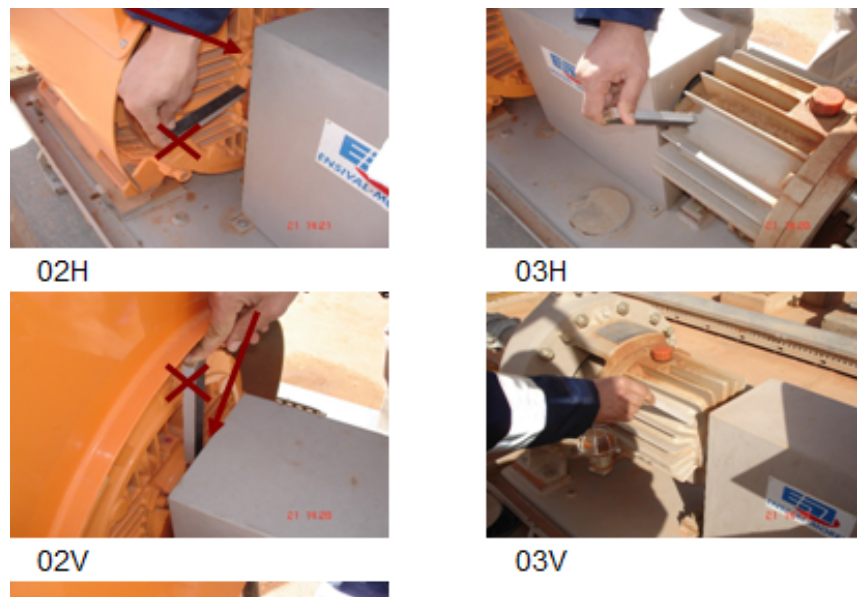
FIGURE 4.11 – les points de mesure des vibrations de la pompe
