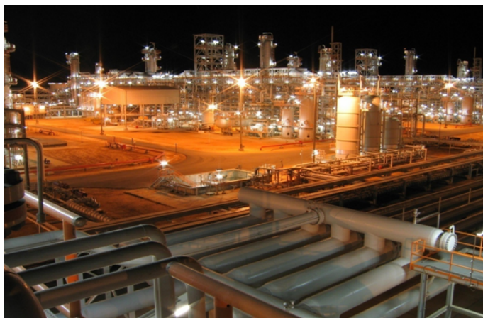
FIGURE 1.3 – l'unité centrale de traitement de gaz (CPF).
