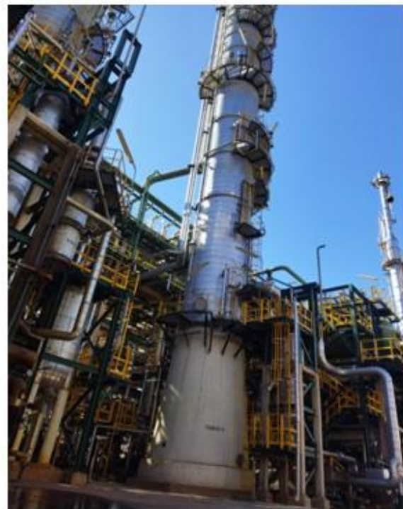
FIGURE I-8: COLONNE DEISOPENTANISEUR 700-C1
