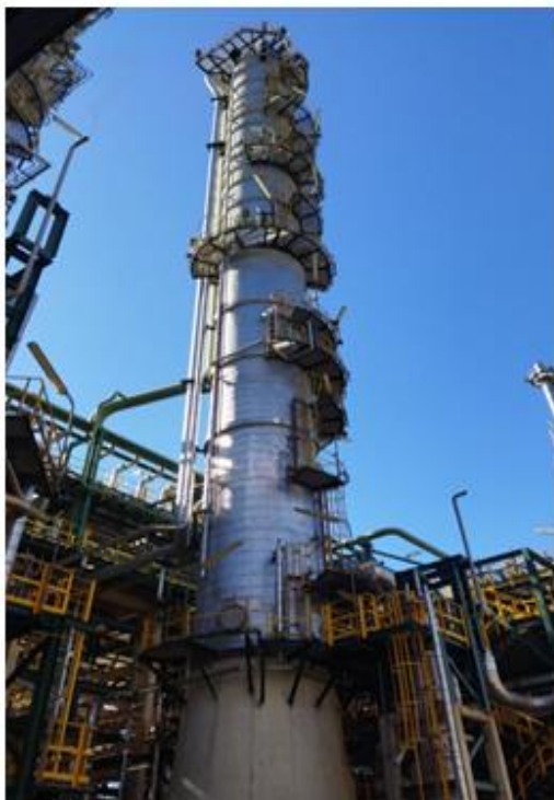
FIGURE I-8: COLONNE DEISOPENTANISEUR 700-C1
