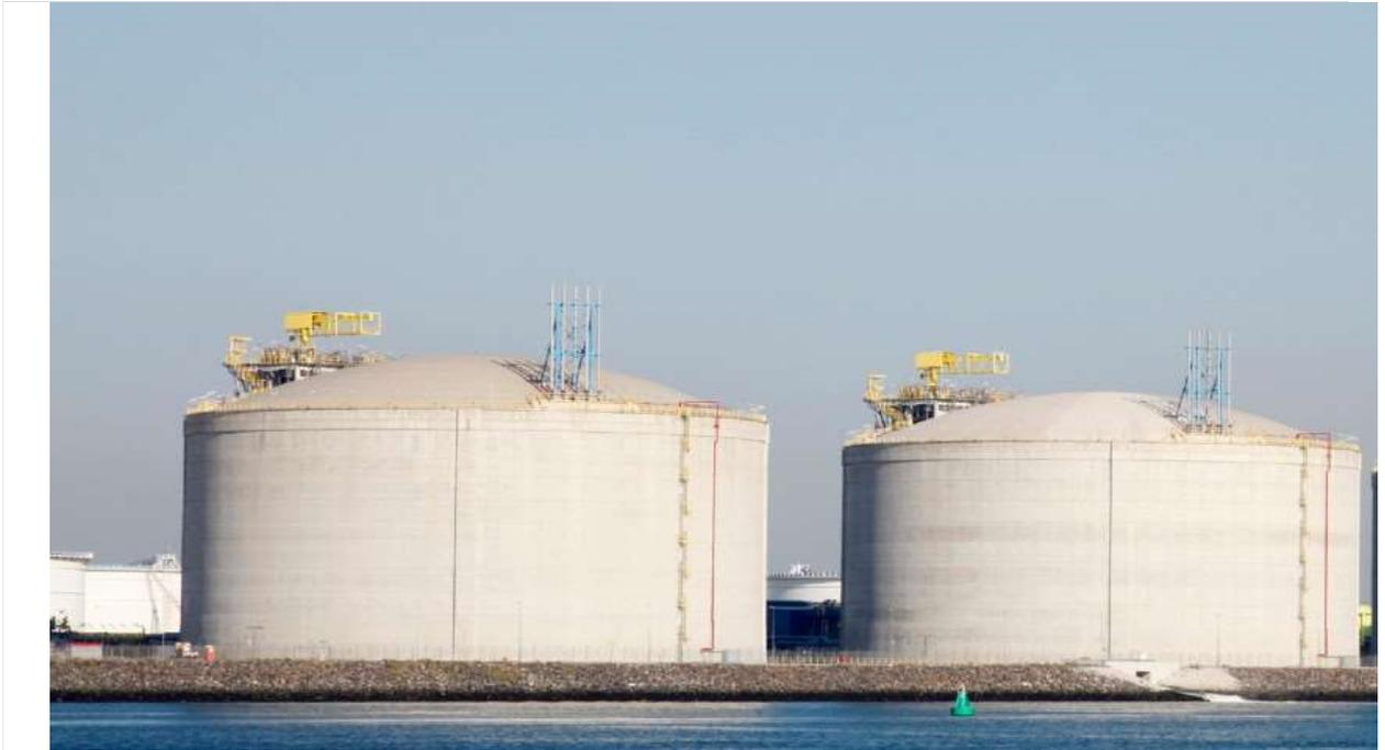
**Figure I. 5: : réservoirs de stockage cylindrique vertical**
