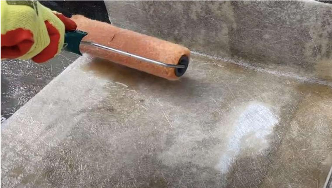
Figure V.13 : les fibres de verre couchées à l'aide d'un rouleau
