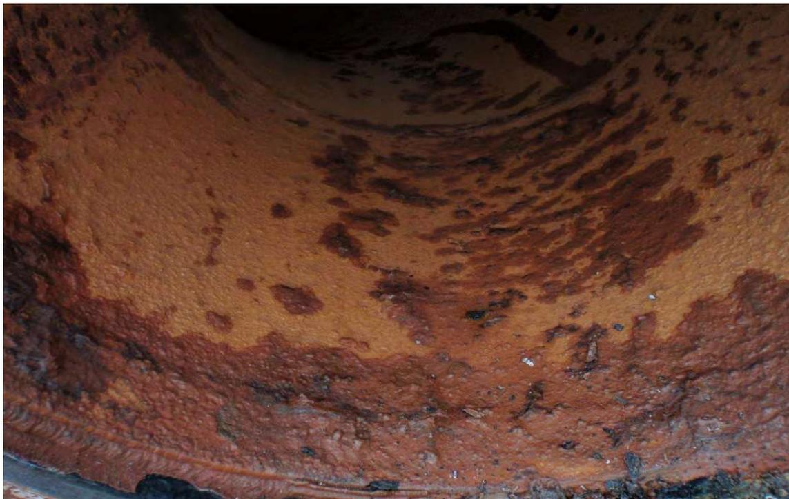
**Figure II. 9: Vue rapprochée de la corrosion par la saumure**
