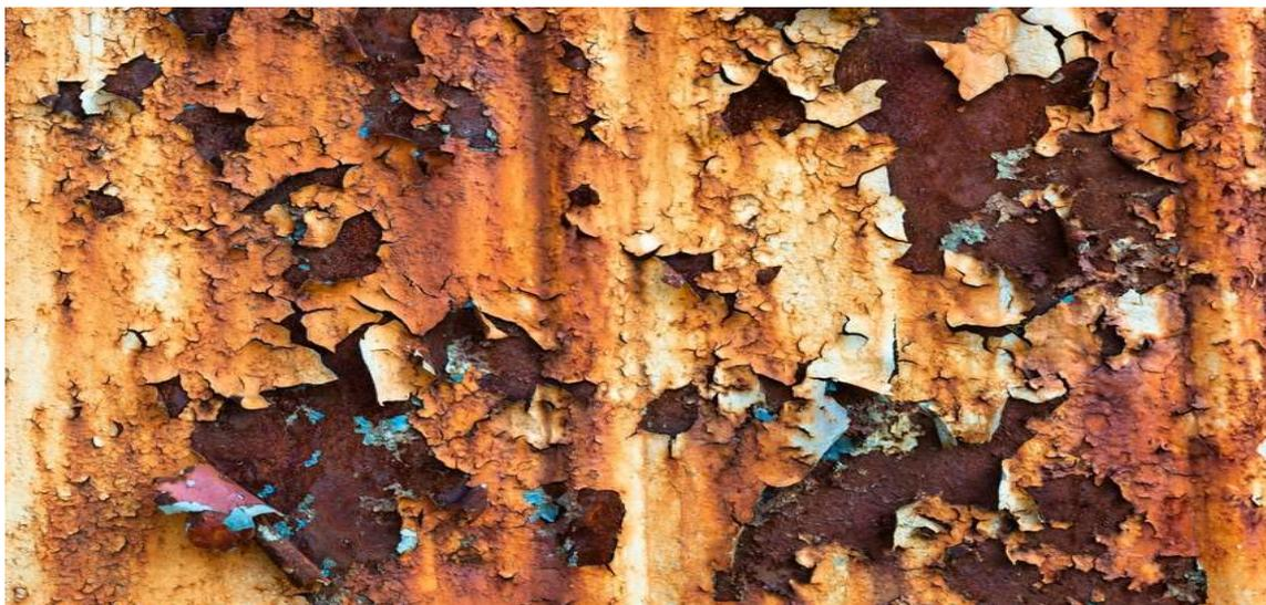
**Figure II. 5: corrosion externe de la virole**
