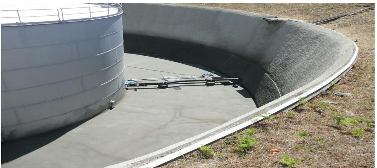
Figure I. 23: la cuvette de rétention.
