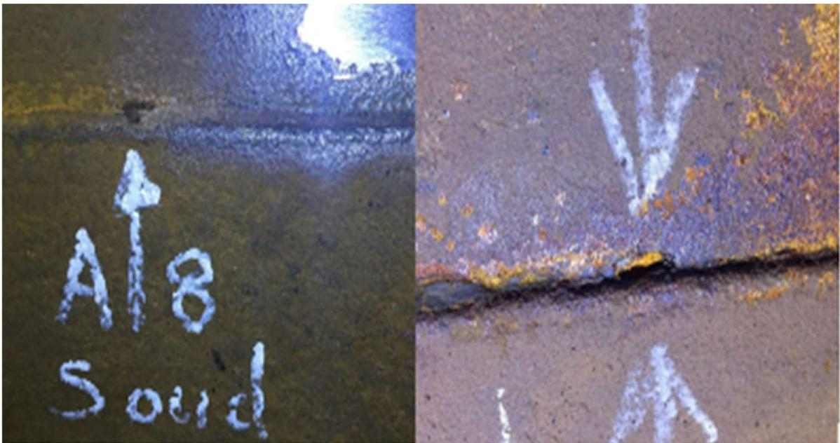
Figure IV.29 : Défauts dans les joints de soudure
