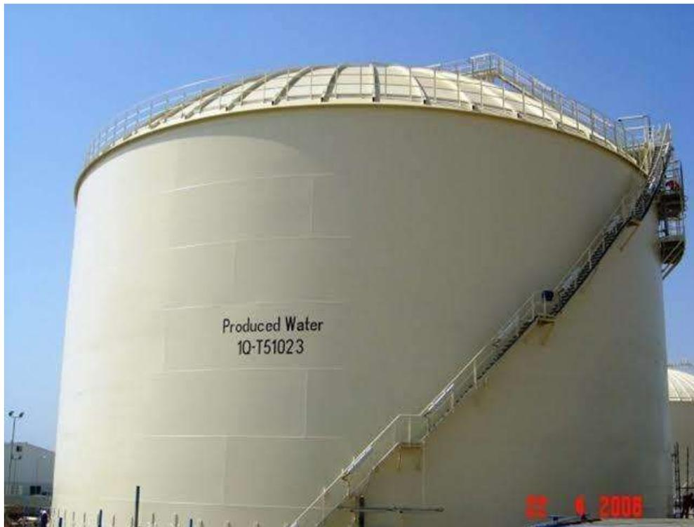
**Figure I. 10: Réservoir à toit Fixe.**
