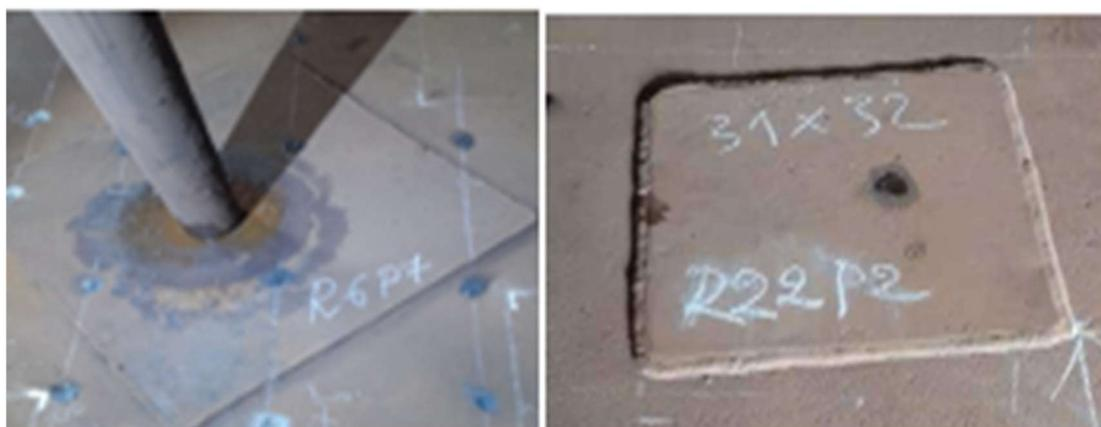
Figure III. 23: support du toit flottant et rustine
