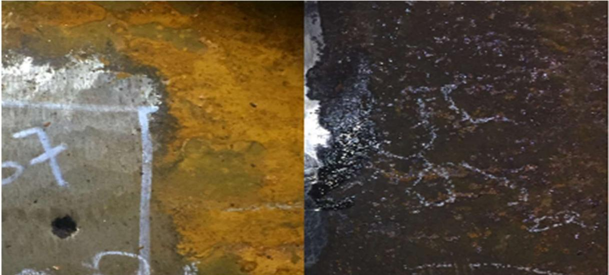
Figure IV. 28: Corrosion généralisée visible à l'œil nue
