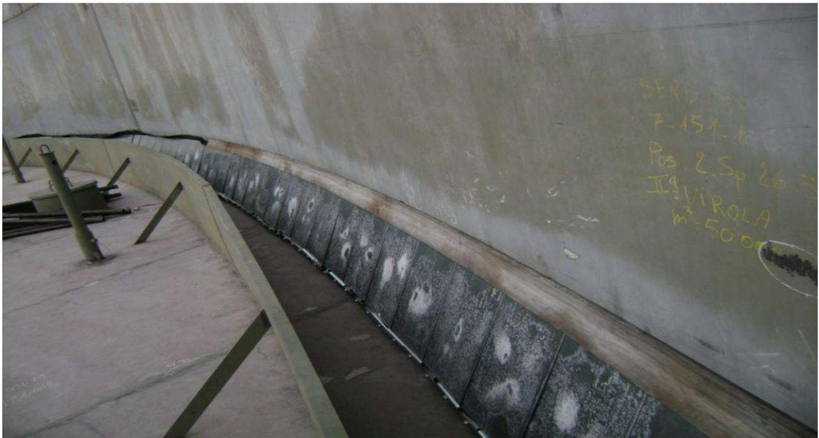
**Figure I. 33: Joint secondaire**
