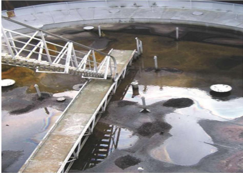
Figure II. 6: corrosion d'un toit flottant
