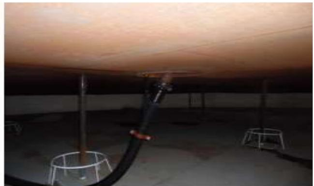
Figure II.7 : la corrosion au niveau des caissons de flottaison, du toit et les béquilles
