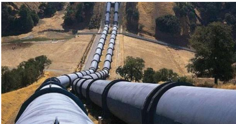
Figure I.3 : Canalisation aérienne.
