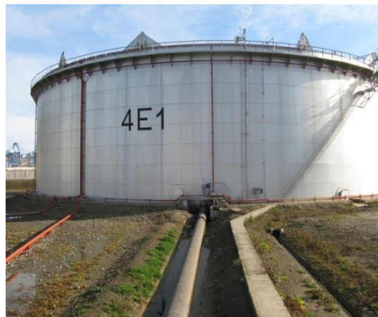
Figure I.7 : Bac de stockage 4E1
