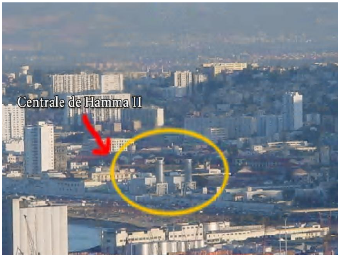
Figure. I.1: Vue externe de la centrale.
