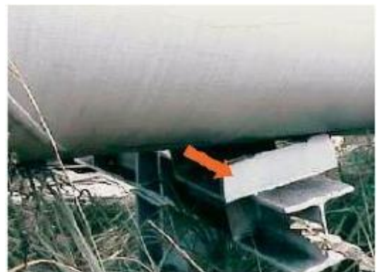
Figure II.6 : Appui détruit.
