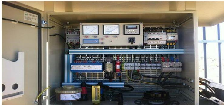
**Figure II.32 :** Le transformateur-redresseur
