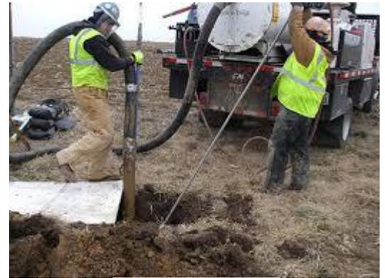
Figure III.7 : Pompage de backfill
