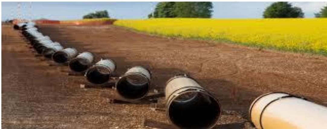
**Figure.VI. 3:** la mise en position des tubes nouveaux.
