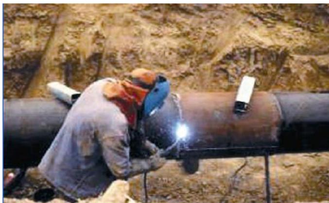
**Figure V.5:**Opération de soudages de demi-coquilles.
