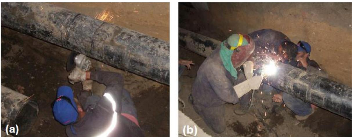
**Figure V.8:** Changeement du tronçon endommagé d'une canalisation, (a) découpage, (b) ré-soudage.
