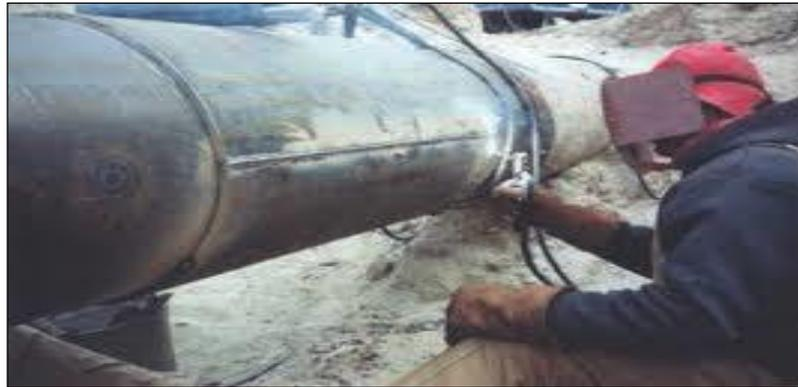
**Figure V.6:** Opération de soudure d'une demi-coquille.
