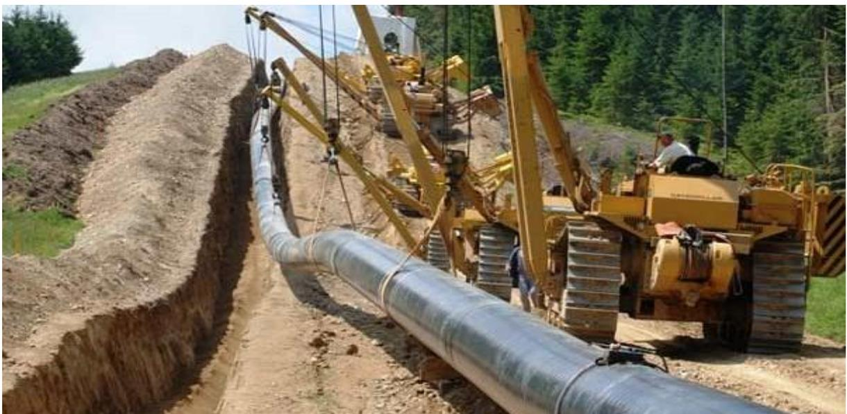
**Figure.VI. 1** : installation d'un nouveau tronçon.
