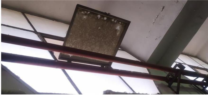
**Figure 3.10 :** Tuyaux de transfert d'huile de la rame 1 non isolé
