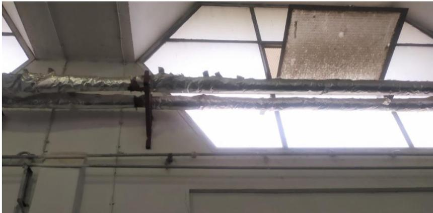
**Figure 3.11:** Tuyaux de transfert d'huile de la rame 2 isolé
