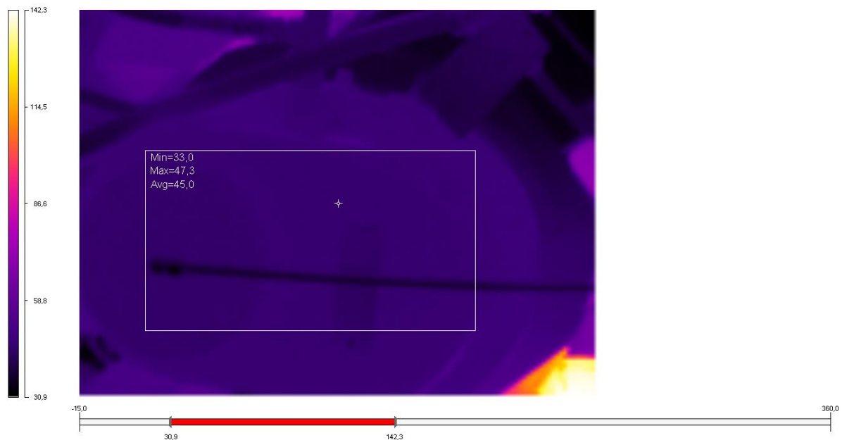
Figure IV.32 : Thermogramme du 1ere étage compresseur
