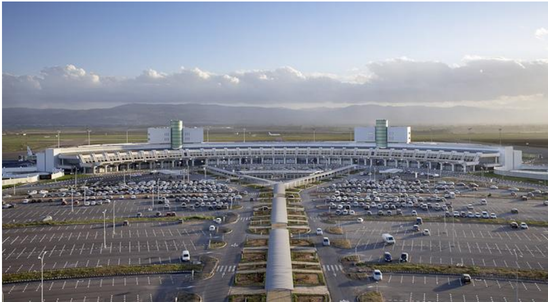
Figure (I-1) : Aéroport d'Alger Houari Boumédiène
