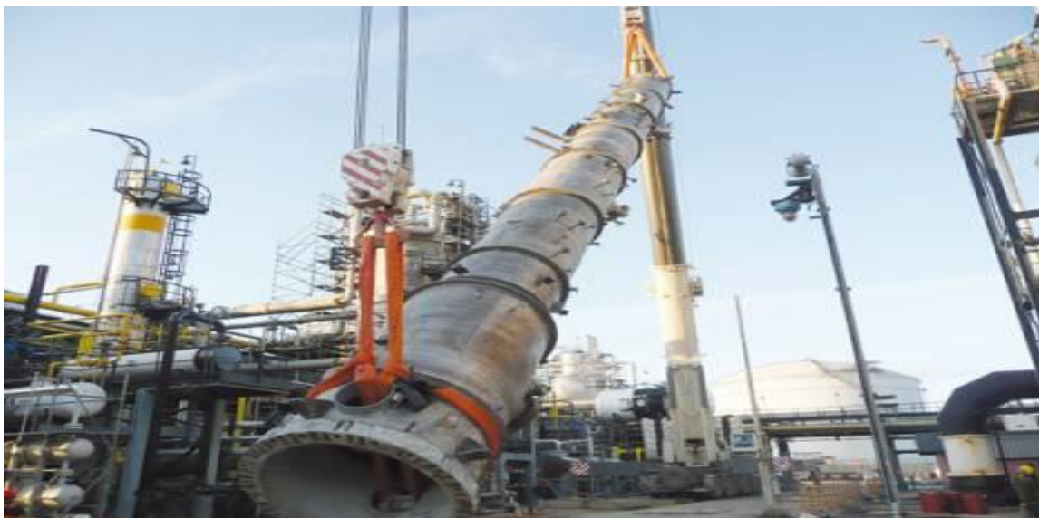
Fig .V.8. La mise en place d'une colonne
