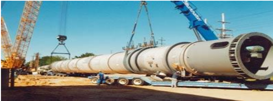
Fig .V.7 Transport et déchargement d'une colonne.
